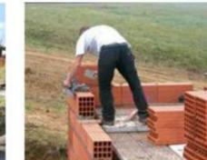
空心砌块，采用多孔砖进行墙体结构保温
