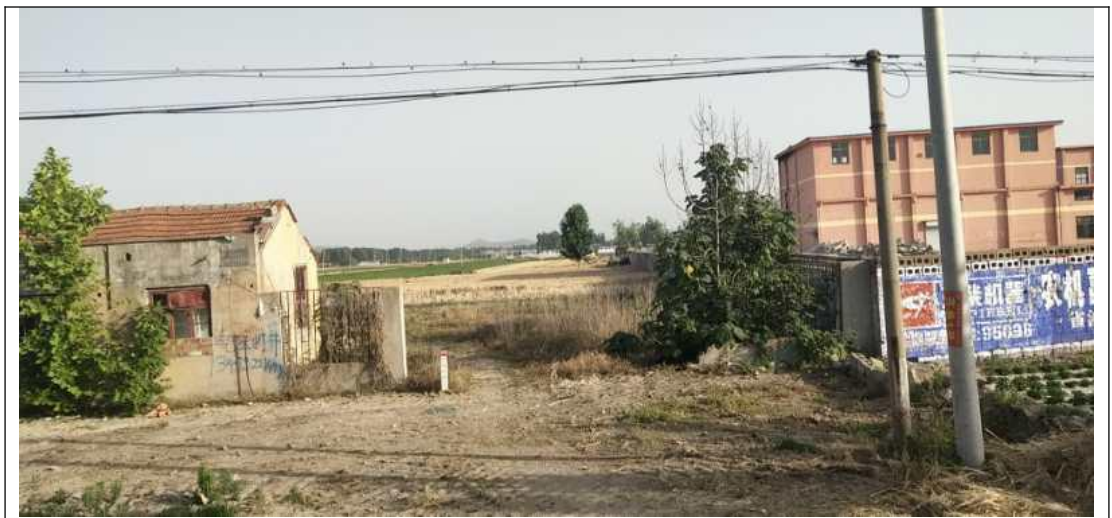
项目现场照片
