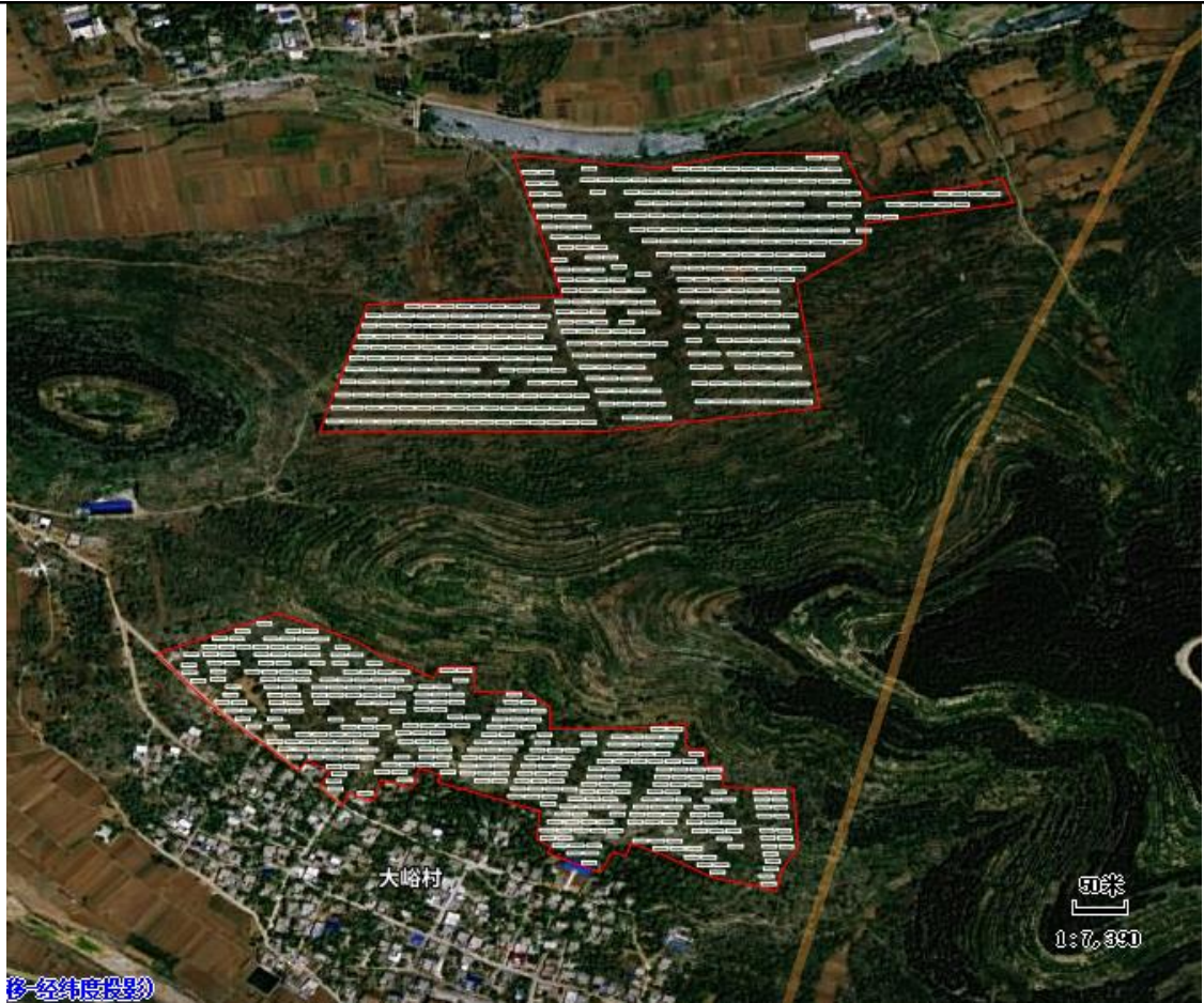
图 5 光伏阵列 4、5 区太阳能板分布情况
