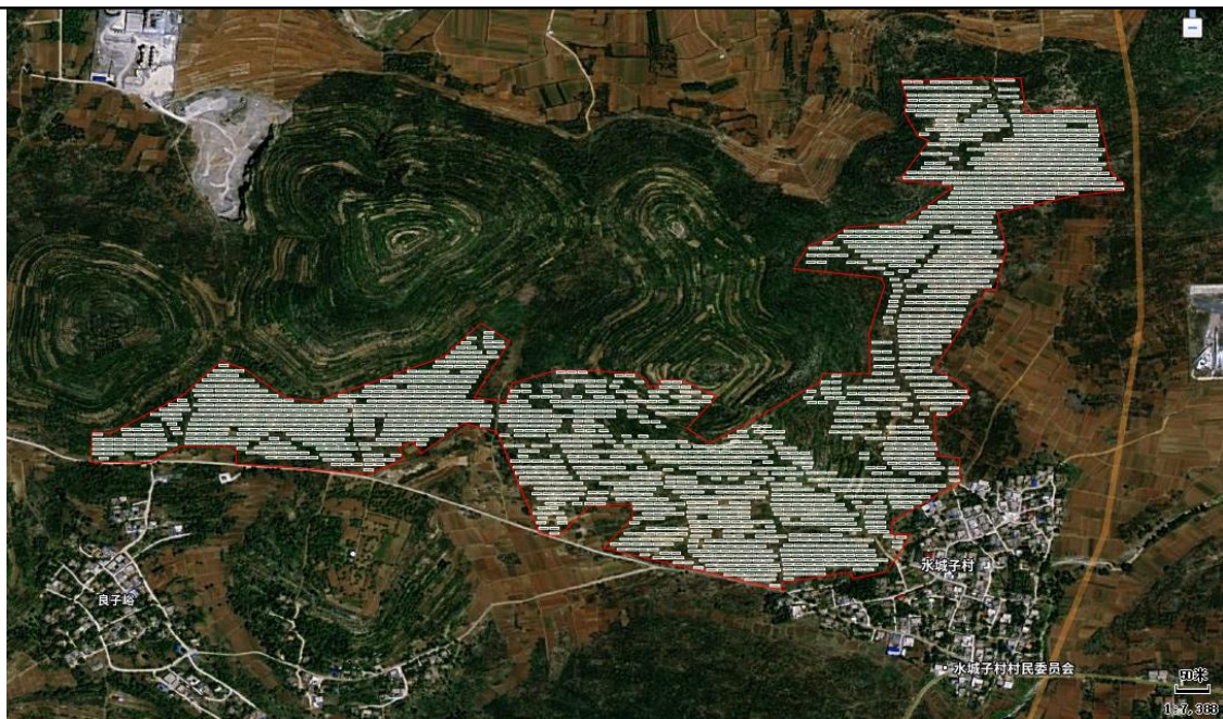
图3 光伏阵列1区太阳能板分布情况
