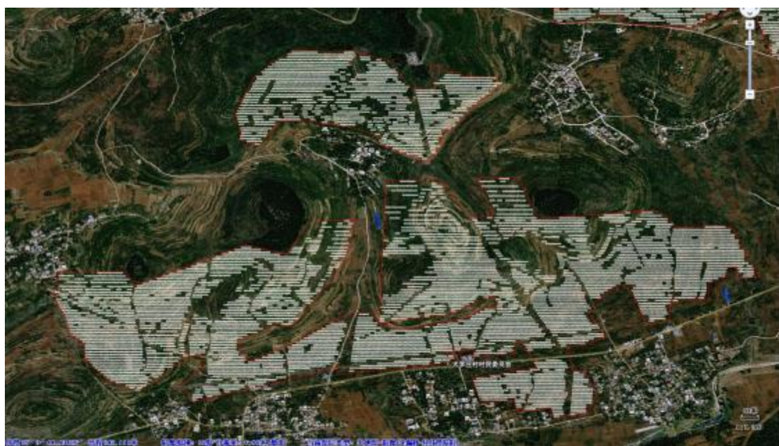
图 4 光伏阵列 2、3 区太阳能板分布情况
