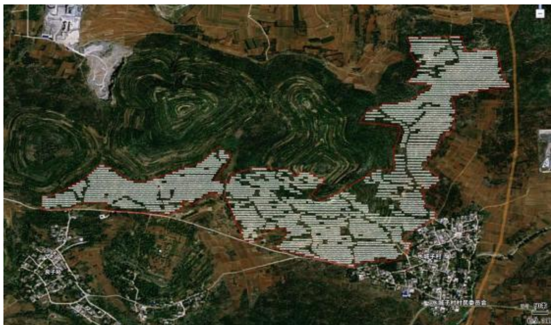
图 3 光伏阵列 1 区太阳能板分布情况
