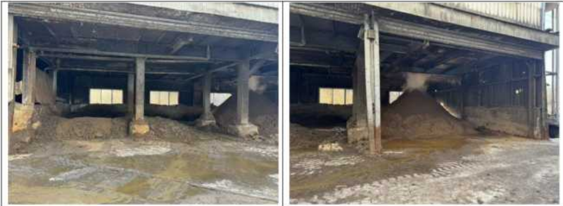
一般固废暂存间现状
